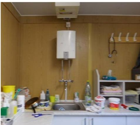
In dem Vet-Container wurde der unzureichende Mini-Warmwassererzeuger gegen einen 5 Liter Boiler mit passendem Stromanschluss ausgetauscht, um das für eine tierärztliche Behandlung erforderliche Warmwasser zu gewährleisten.
