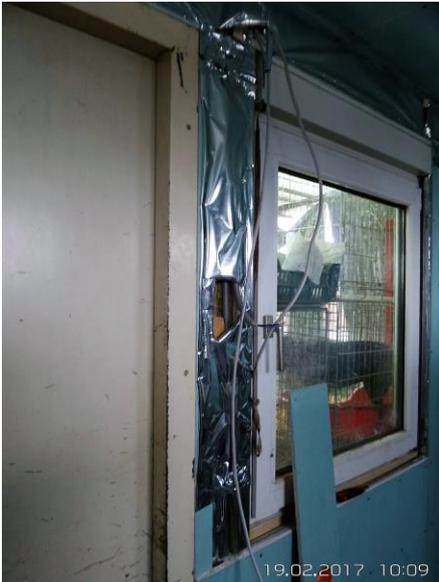
Lampen im Container sind erstmal die alten angebaut, leider waren die Klemmen für die Abdeckungen, bis auf zwei, nicht auffindbar. Der Container hat drei getrennte Stromkreise. Einer für Licht und Steckdosen, ein weiterer für die Steckdosen an der Decke zum Betreiben der noch zu installierenden Heizplatten sowie ein Stromkreis für den Freibereich.
